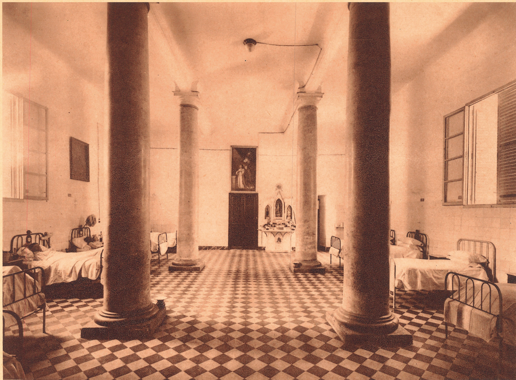
Enfermería para lesionados por accidentes del trabajo
