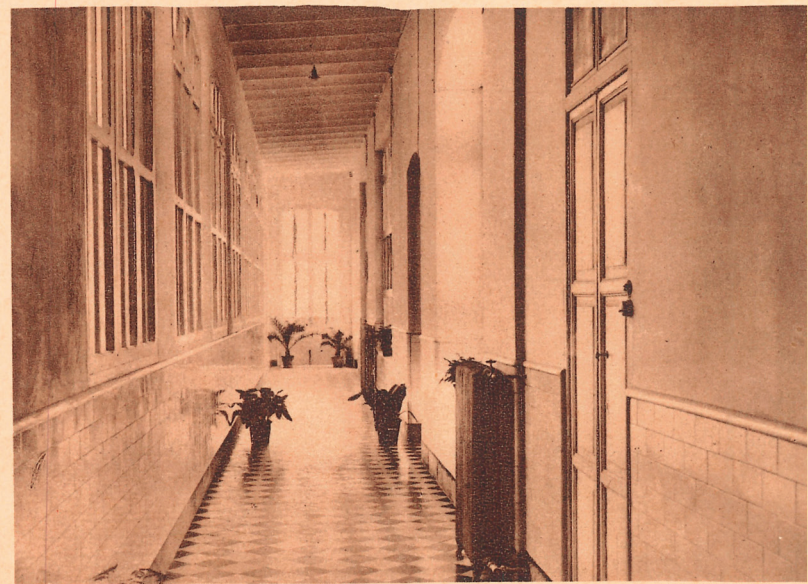
Corredor que conduce a las salas de operaciones
