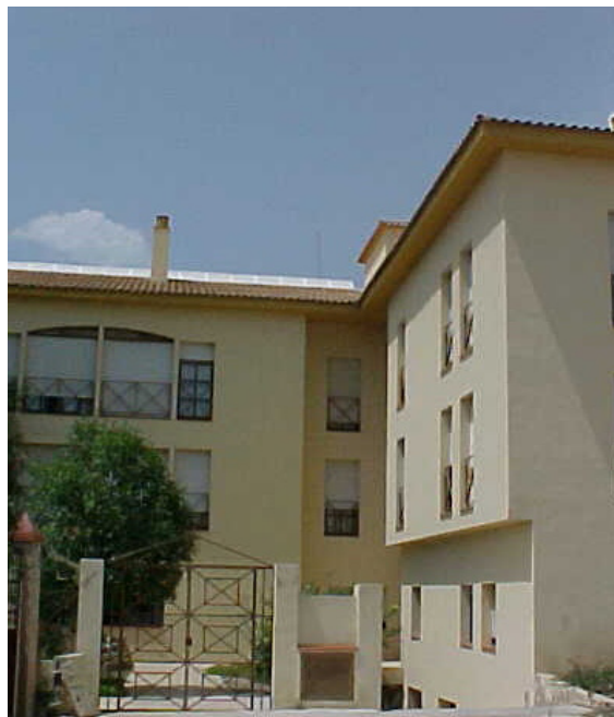
Residencia de la tercera edad ubicada en la población de Chelva.
